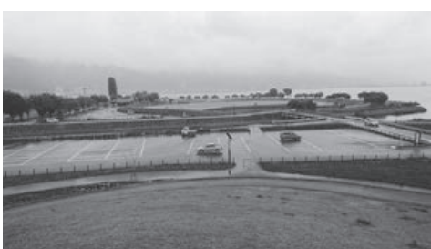
完成した赤砂崎公園
